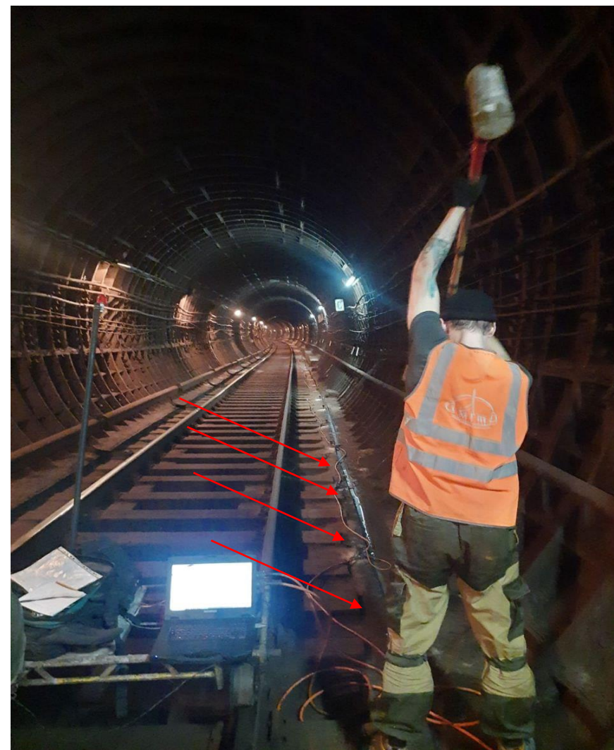
Выполнение работ методом МПВ. Красными стрелками показано положение датчиков
